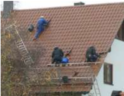
00619.jpg: „Glücksspiel“ auf dem Dach betreiben viele Solarteure, die ungesichert in schwindelnder Höhe arbeiten.
