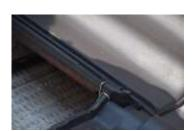
**00615.jpg**: Schutz vor Sturm: Die Windsogsicherung – z. B. durch Verklammern – ist seit Jahren bei Neueindeckungen und umfassenden Sanierungen vorgeschrieben.
