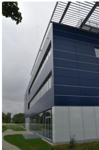
**00598.jpg:** Bis zu annähernd einem Fünftel kann der Energiebedarf durch vorgehängte hinterlüftete Fassaden vom Dachdecker gesenkt werden.
