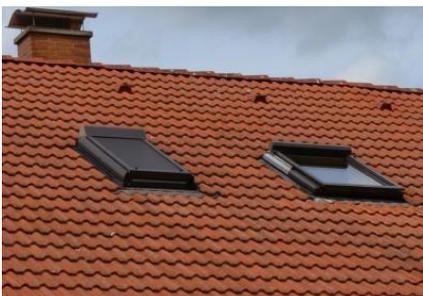
**00569.jpg:** Der „Sonnenschirm“ für die Dachwohnung – Sonnenschutz-Rollos können manuell oder automatisch gesteuert werden.
