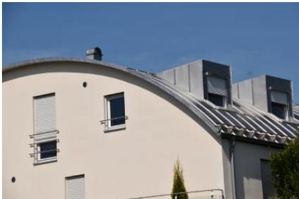
**00567.jpg:** Auch wenn auf einer solchen Dachfläche im Sommer „Backblech-Temperaturen“ erreicht werden, muss ein angenehmes Raumklima unter dem Dach gewährleistet sein.
