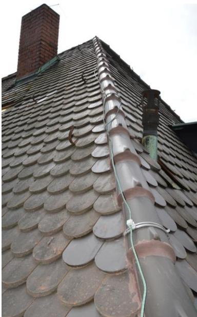
**00539.jpg:** Auch der Blitzschutz sowie die Durchdringungen z. B. für Lüfterrohre werden beim DachCheck einer Sichtprüfung unterzogen.
