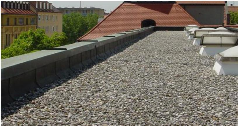
**00551.jpg:** Ohne Notentwässerung in der umlaufenden Attika können bei einem Starkregen binnen weniger Minuten mehrere Tonnen Wasser die Statik dieses Flachdachs an ihre Grenzen bringen.
