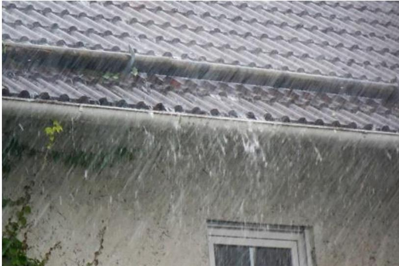
**00550.jpg:** Die Dachrinne zu klein dimensioniert und schon lange nicht mehr gereinigt worden. Schon bei einem kurzen Starkregen ist die Wasserabführung am Ende.
