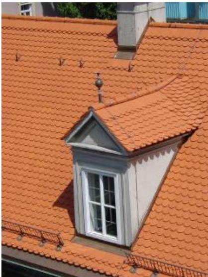
**00186.jpg:** Die hohe Kunst des Dachdeckerhandwerks zeigt sich bei der Eindeckung mit keramischen Biberschwanzziegeln und dem fließenden Übergang zur Gaube, dem kupfernen Dachschmuck und des Blitzschutzes.
