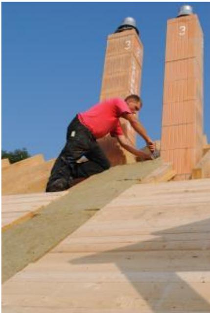
**00544.jpg:** Hier wird effektiver Wärme- und Kälteschutz eingebaut. Eine gute Wärmedämmung schützt im Sommer, spart Heizkosten im Winter und reduziert den CO<sub>2</sub>-Ausstoß.
