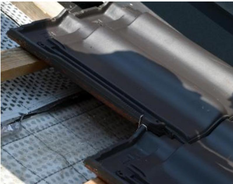
**00559.jpg:** Mit Sturmkammern werden Dachziegel und Dachpfannen zuverlässig vor dem Windsog gesichert.
