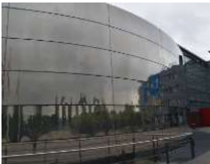
00593.jpg: Eine homogene Außenwand, die schützt und Energie spart, kann mit VHF-Systemen realisiert werden.
