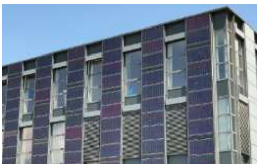
00590.jpg: Die Schutz- und Nutzfunktion der vorgehängten hinterlüfteten Fassade kann um die Nutzfunktion der Energieerzeugung per Sonnenkraft erweitert werden.
