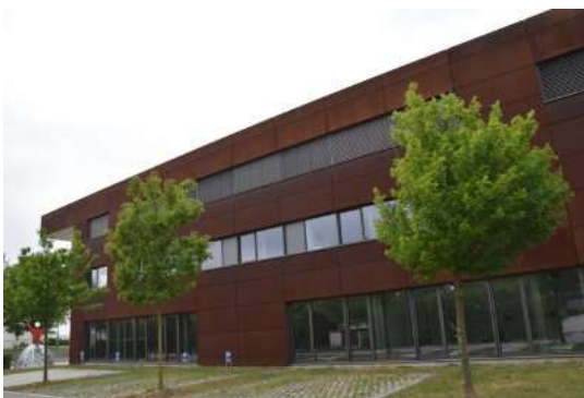
00592.jpg: Die Fassade im „coolen“ Metall-Look.
