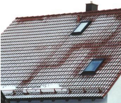
**00269.jpg:** Deutlich zeichnet sich hier der Grundriss der Dachwohnung ab. Ein Zeichen für – durchaus vermeidbare – Wärmebrücken im Dämmbereich.
