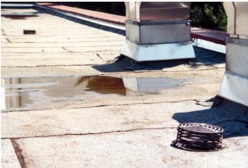
**00176.jpg:** Gerade beim Flachdach können bei Starkregen durch eine nicht mehr funktionierende Wasserabführung aus kleinen Pfützen ganze „Seenlandschaften“ werden.
